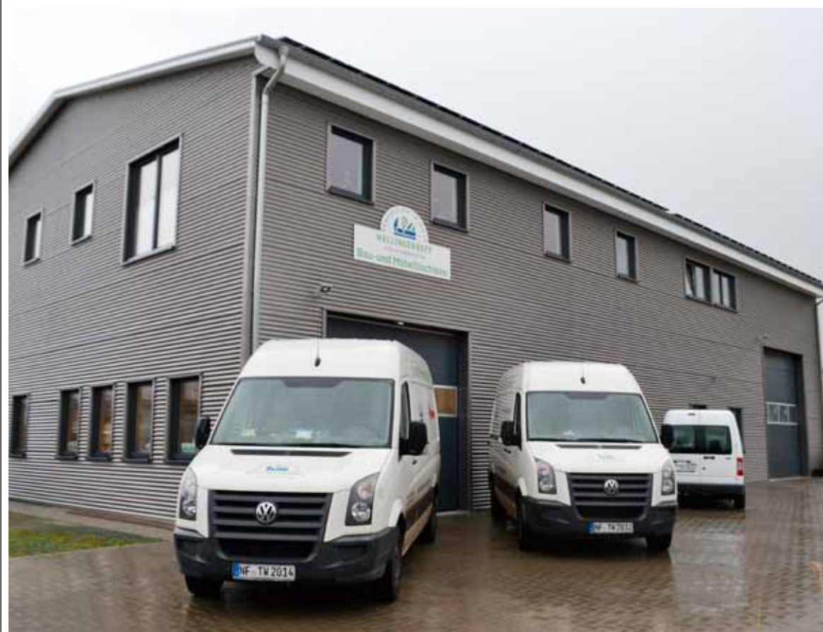
Die neue Halle mit einer Fläche von 800 Quadratmetern
